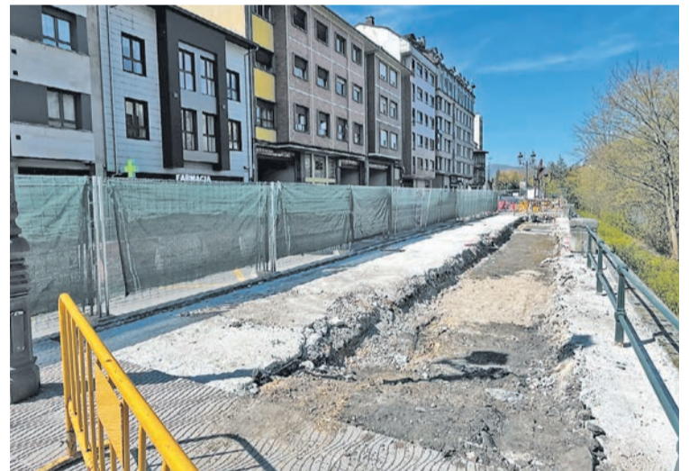
Obras de construcción de la nueva marquesina de autobuses de Sama.
