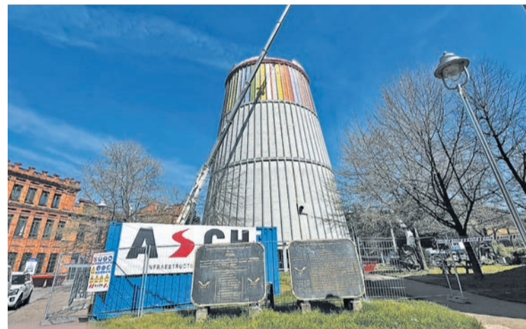
El MUSI en plenas obras de rehabilitación.
