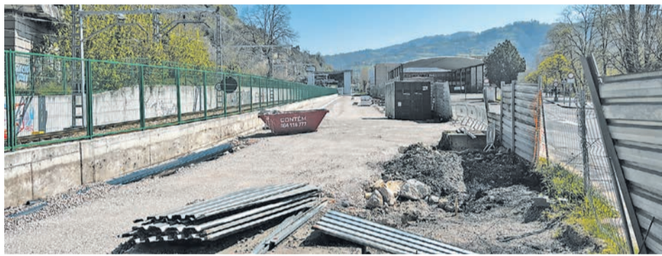
Obras en el paseo de Los Llerones.
