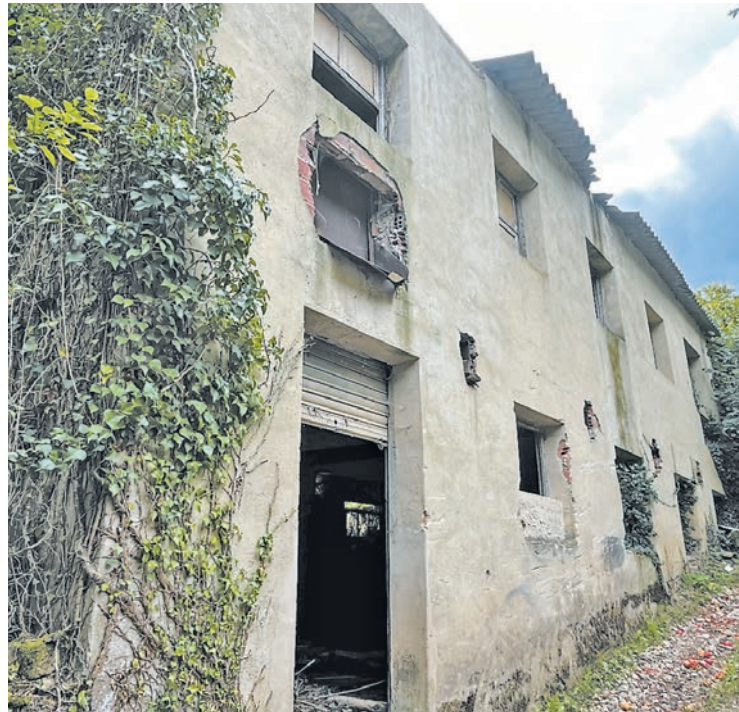
Antigua granja avícola de Villamoréi donde se construirán viviendas sociales.
