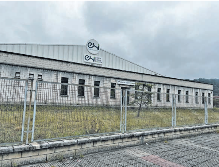
Instalaciones de Exiom.
