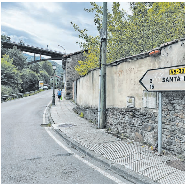
Carretera AS-337, que será reparada.
