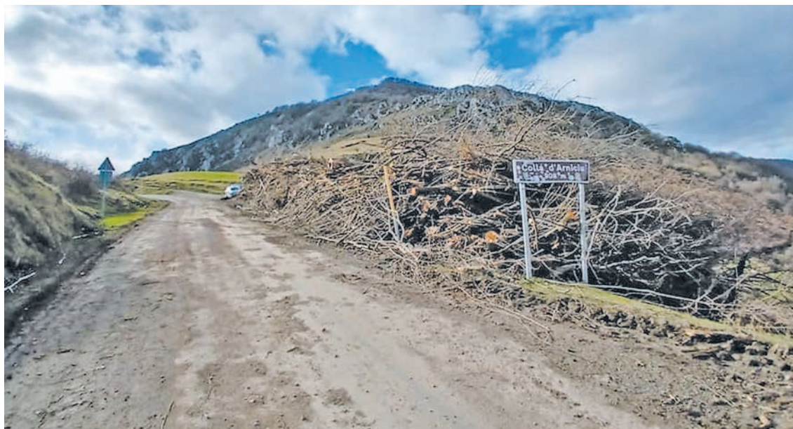
Estado de la carretera AS-254 entre Bueres y La Marea, en obras de mejora.
