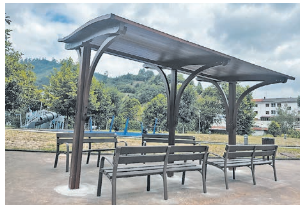
Nueva marquesina en el parque de Barredos.
