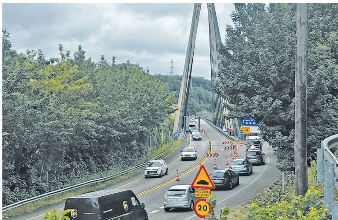
Puente atirantado de Sama, con el carril sentido Oviedo cerrado.
