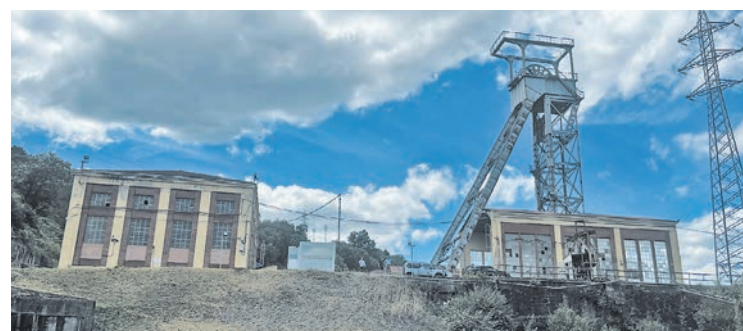
Instalaciones del Pozo Candín.
