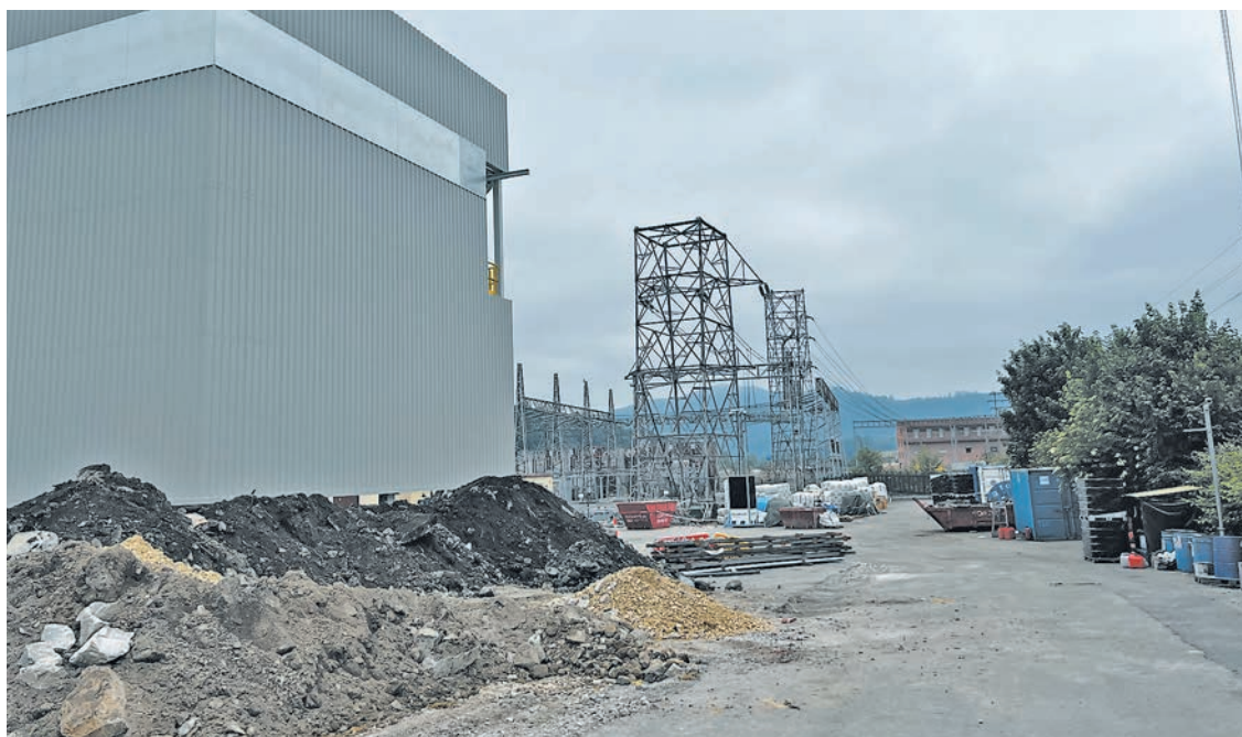
Terrenos de Bayer, con restos de la térmica al fondo.
