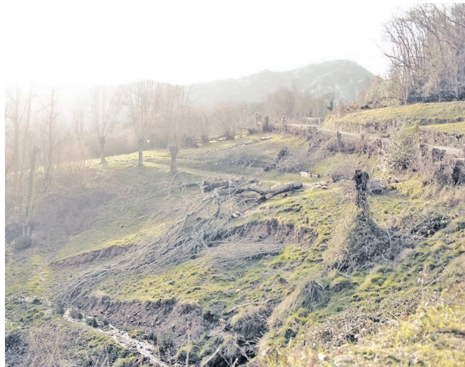
Obras de desbrozamiento para el arreglo de la carretera, en las proximidades de la Collada de Arniciu.
