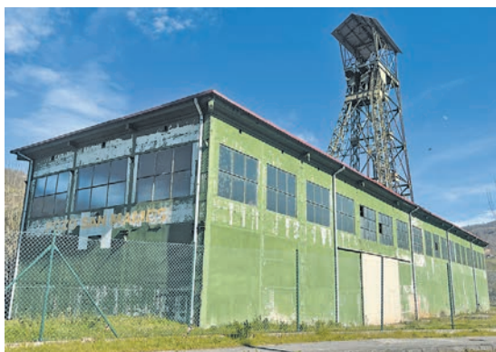
Pozo San Mamés.
