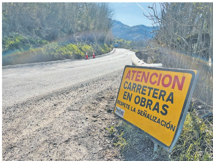
Obras en la carretera AS-252 dirección a Villoria.
