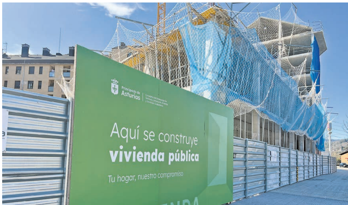
Viviendas públicas en construcción en Langreo.
