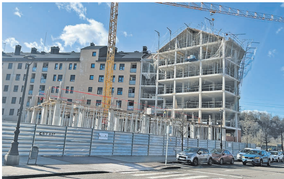
Pisos públicos para jóvenes, en construcción en Langreo Centro.
