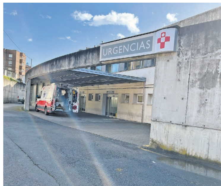
Entrada de acceso a Urgencias del Hospital Valle del Nalón.
