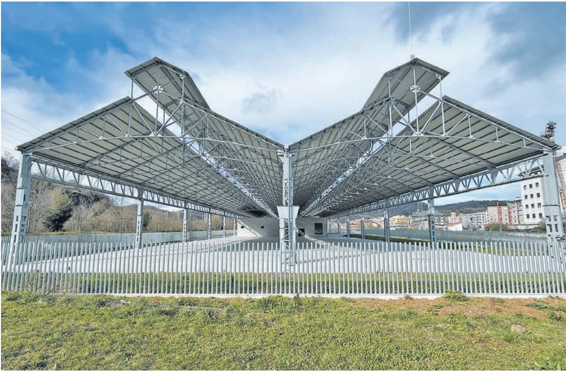
Recinto ferial de los Talleres del Conde, una vez concluidas las obras.
