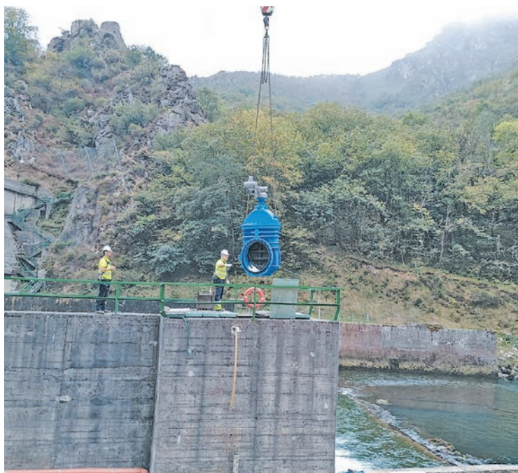
Trabajos de sustitución de una de las válvulas del embalse de Rioseco.
