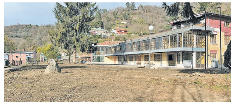
Obras en la zona exterior del complejo El Urogallo.
