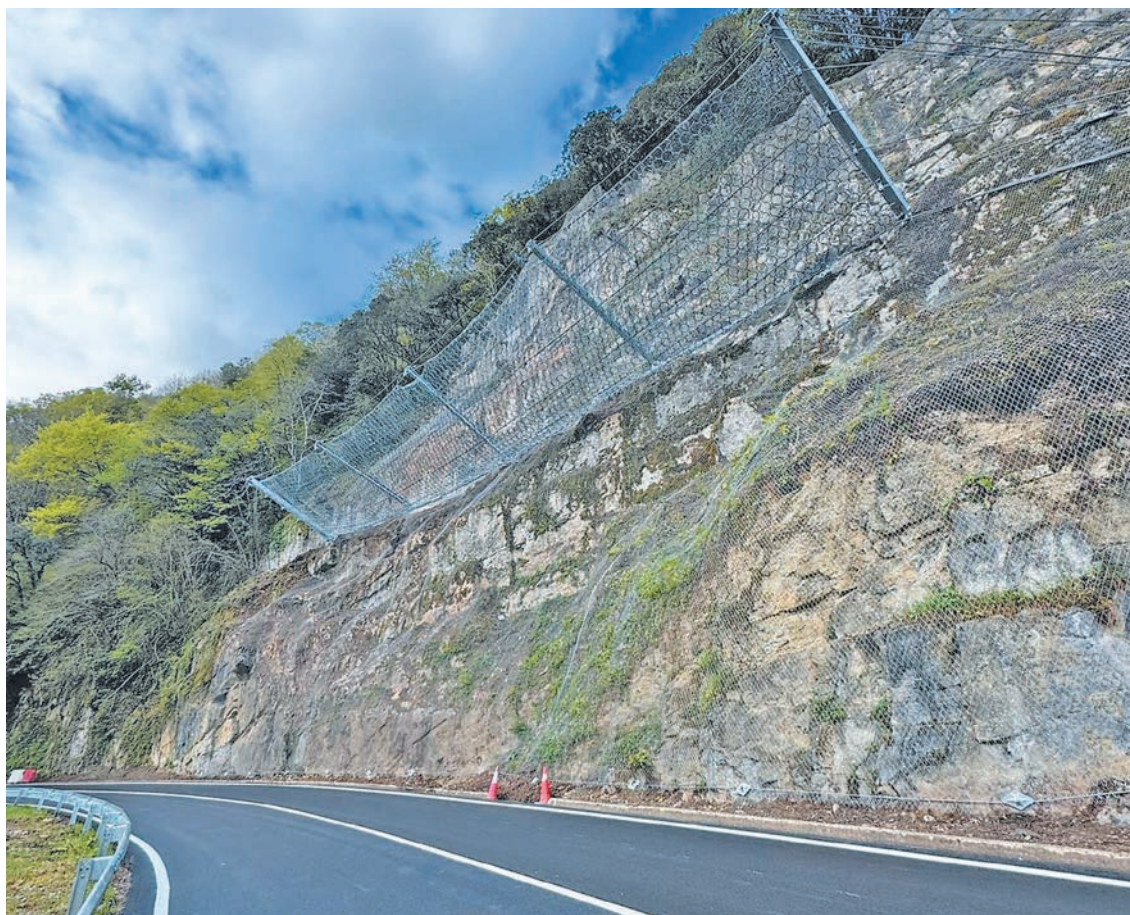
Uno de los taludes arreglado en el Nalón, en el concejo de Caso.
