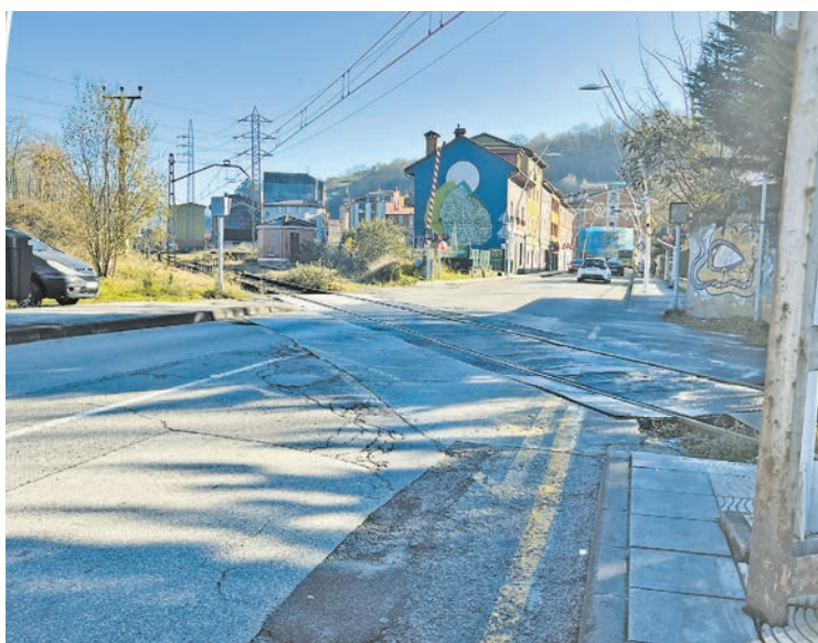
Paso a nivel de Ciaño.
