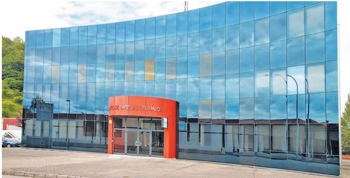
Centro de empresas de SODECO en El Entrego, donde instalará su sede ByteTravel.
