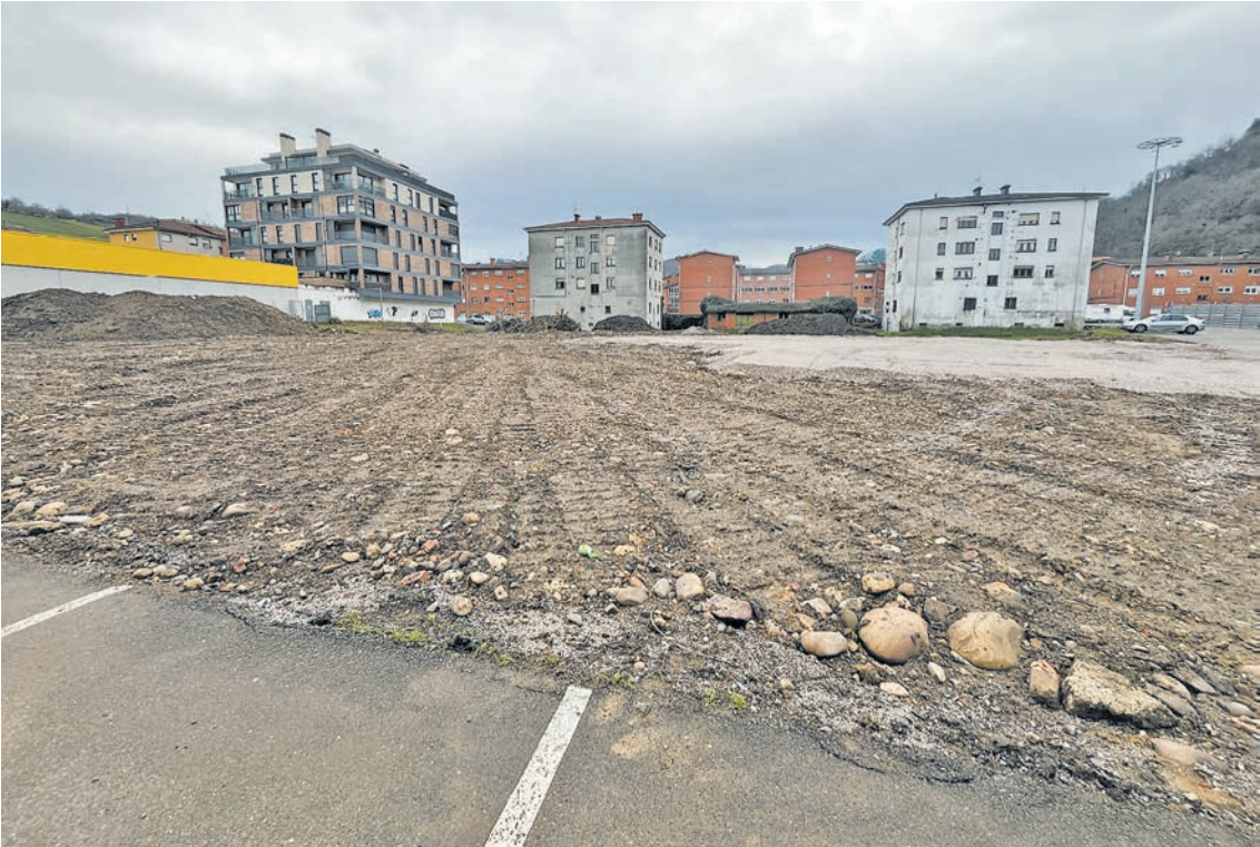
Obras de adecuación del nuevo aparcamiento en La Pola.
