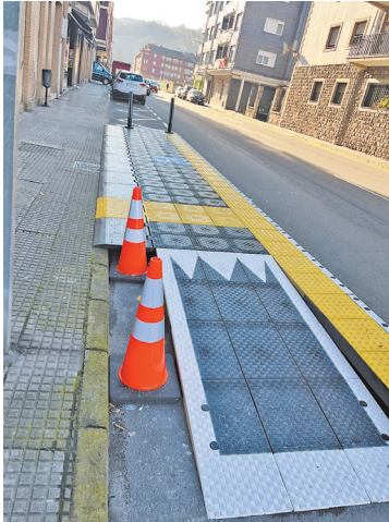
Plataforma para la accesibilidad de personas con movilidad reducida en la parada de la calle Río Cares.
