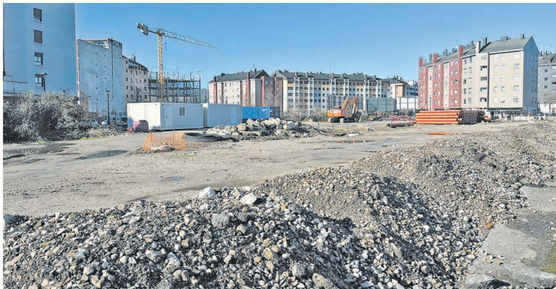
Estado de las obras de drenaje de aguas pluviales en los terrenos liberados del soterramiento.
