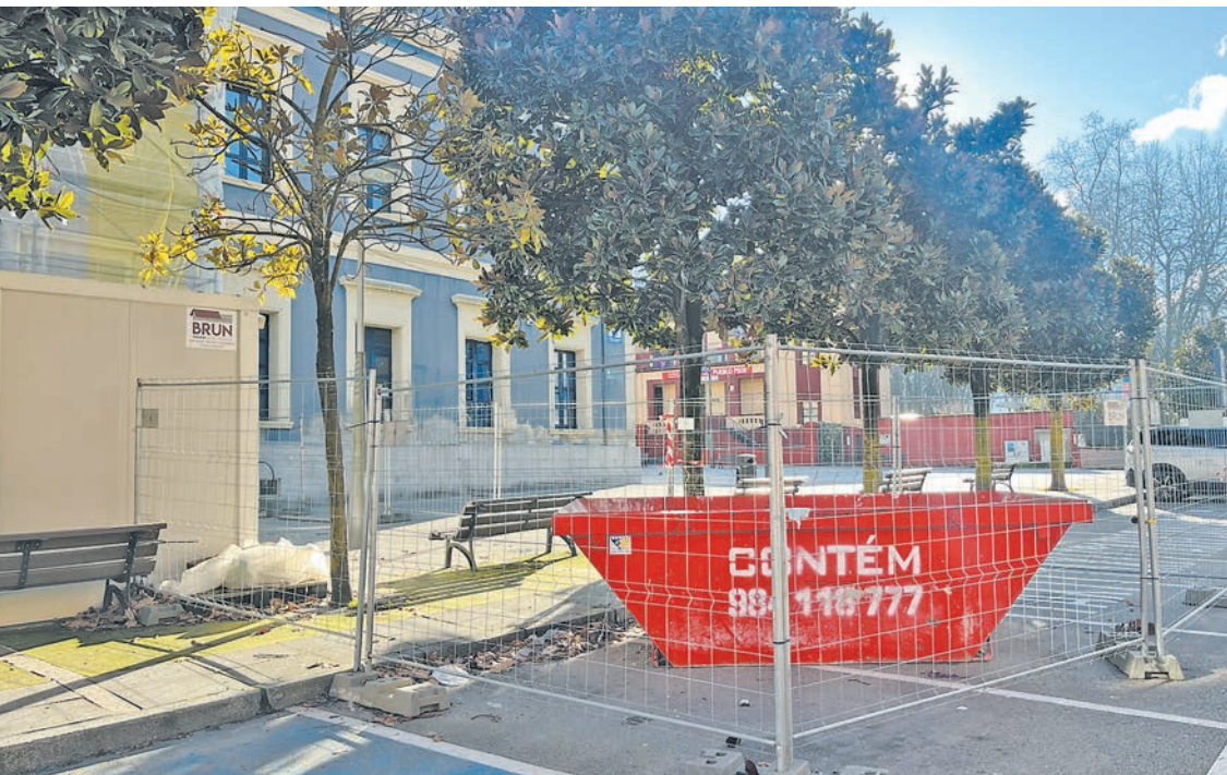
Parte posterior del ayuntamiento de Laviana, donde se habilitará un aparcamiento para bicicletas eléctricas.
