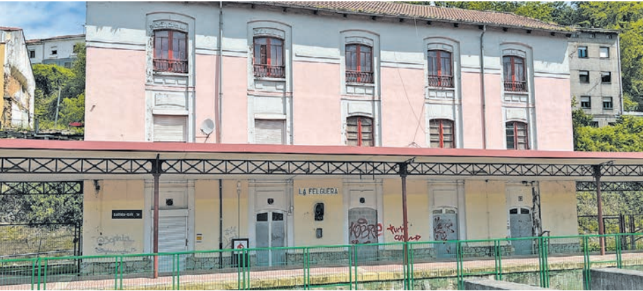
Antigua estación de FEVE de La Felguera.
