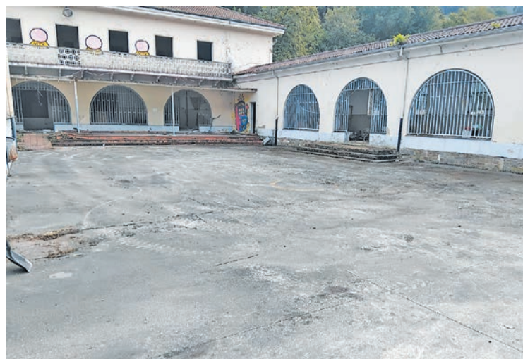
Obras de limpieza y recuperación en el patio del colegio La Salle de Ciaño.
