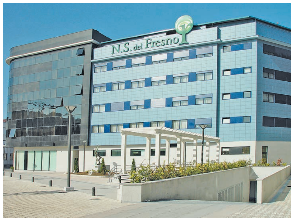
Exterior de la residencia Nª Señora del Fresno en la calle José Arenas de La Felguera.
