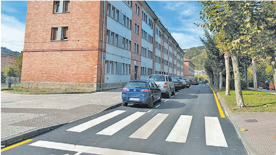
Avenida del Nalón, de El Entrego, tras la pavimentación del vial.
