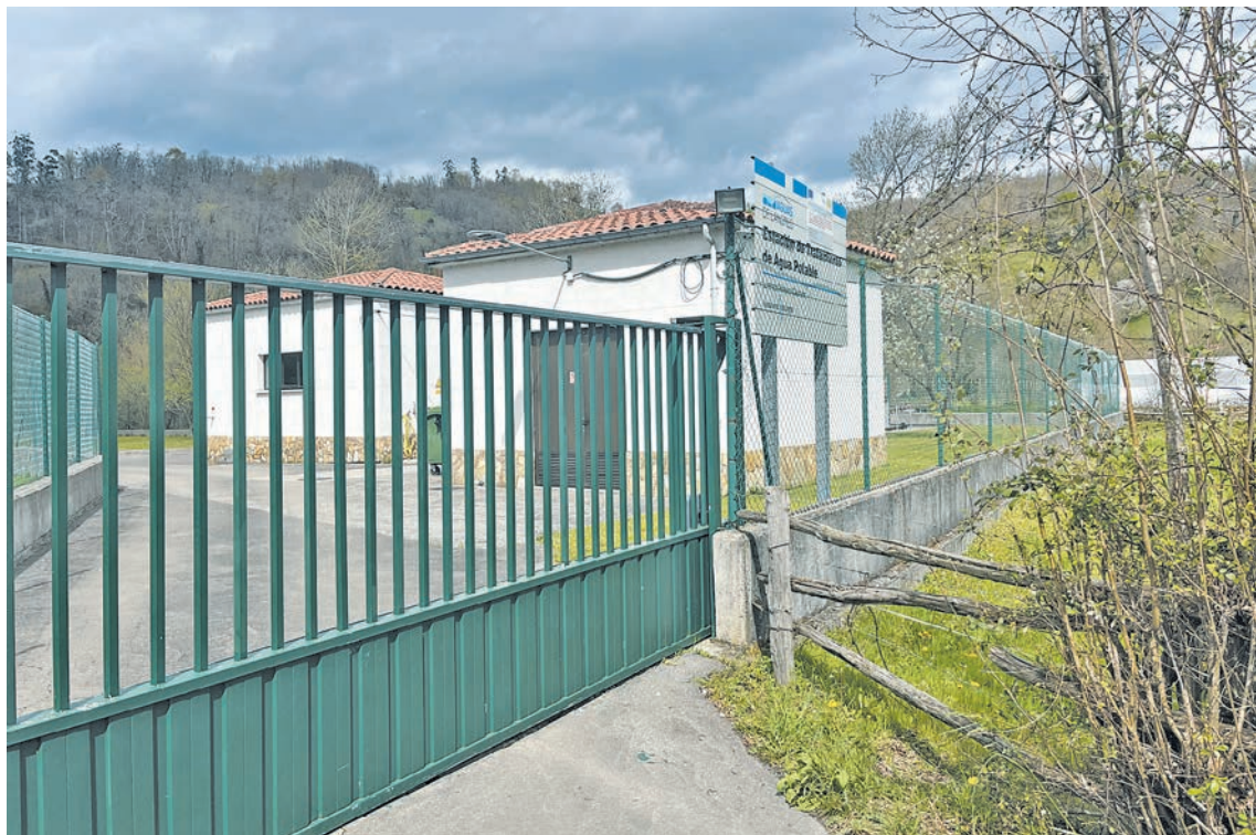
Planta potabilizadora de Aguas de Langreo en Entralgo.
