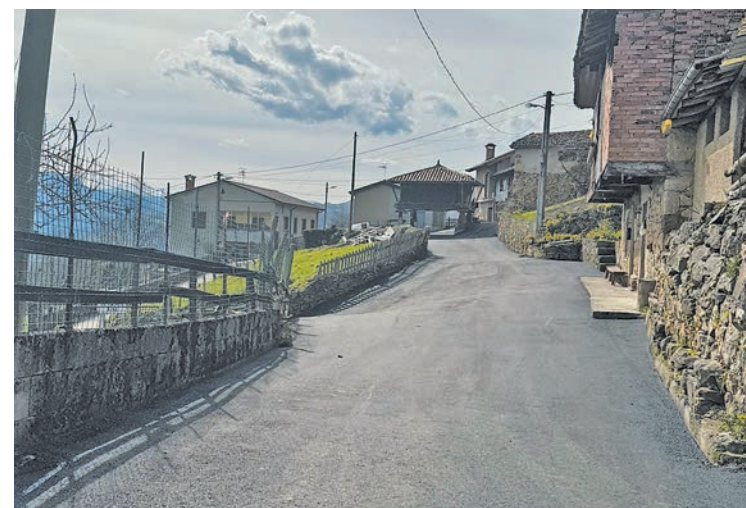
El Cantu tras las obras de abastecimiento de agua y la reparación del asfalto.
