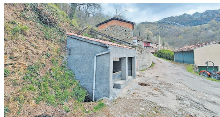
Lavadero de Fresneo tras su rehabilitación.
