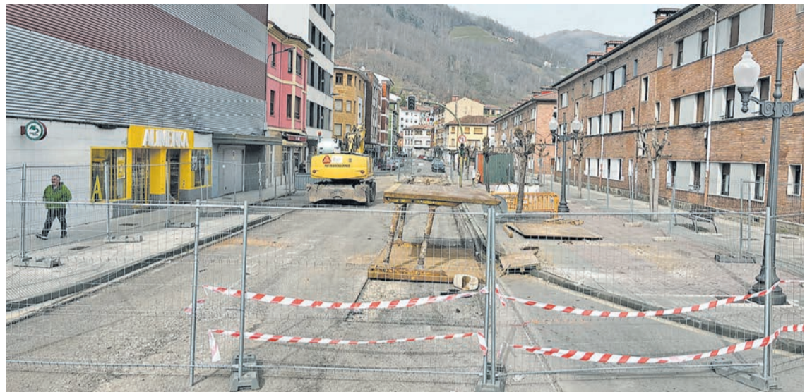
Obras de renovación del colector de Blimea.
