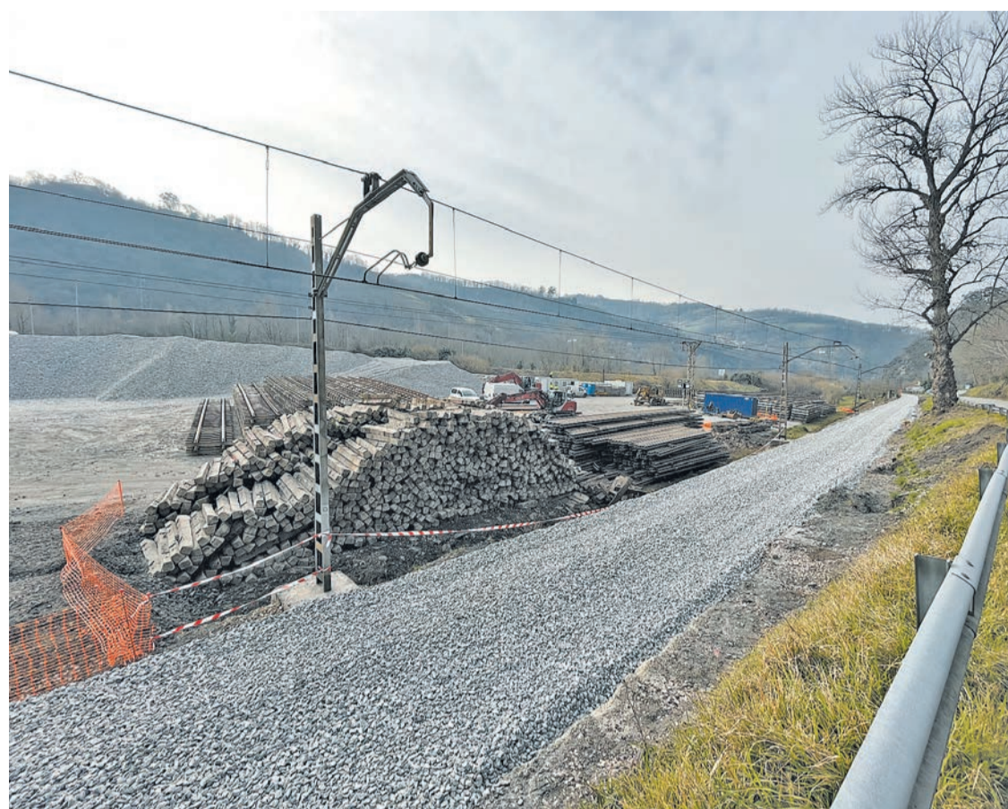
Obras de sustitución de las vías a la altura de Barredos.
